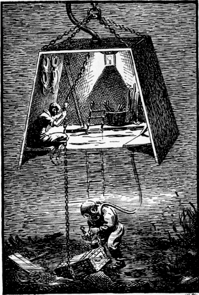
Taucherglocke. Ältere Ausführung, deren grundsätzliche Einrichtung aber auch heute noch beibehalten ist
