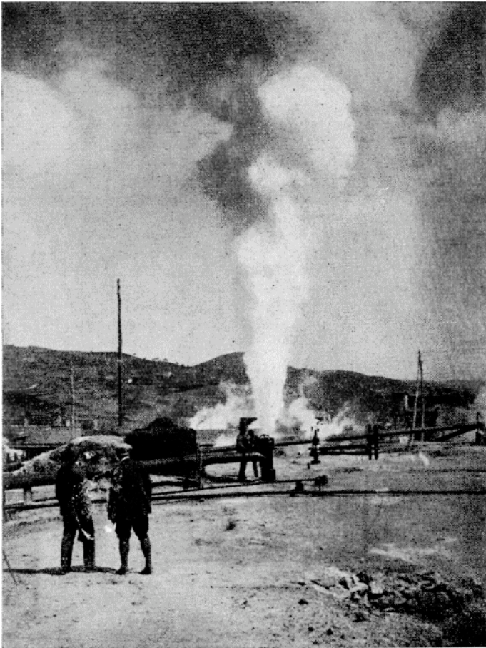
Vulkanischer Dampf als Kraftquelle. Im Val d'Inferno in Toscana wird ein Kraftwerk seit Jahren durch vulkanischen Dampf betrieben, der teils natürlichen Fumarolen, teils Bohrlöchern entquillt
